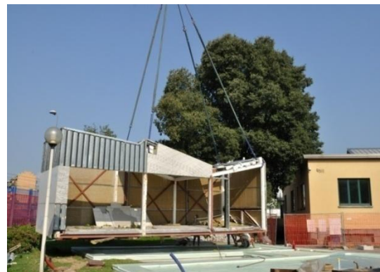
VeluxLAB: inizio del cantiere
